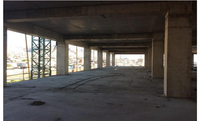
Dispositivos instalados en edificio TH
