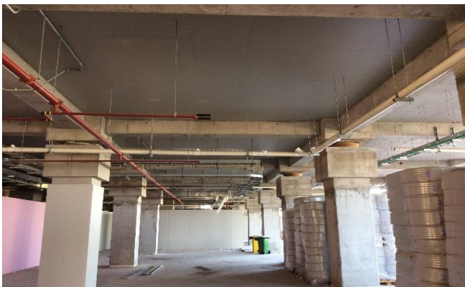
Avance losa hormigonada en edificio UPC
