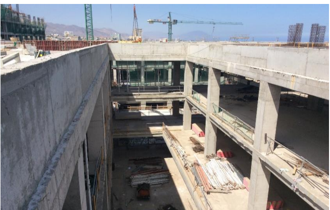
Avance en la colocación de hormigón en Centro Diagnostico Terapéutico CDT
