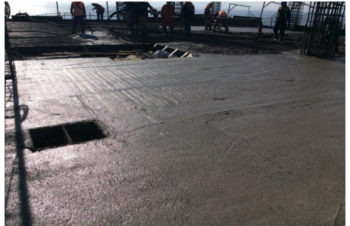
Avance losa nivel 7 edificio TH
