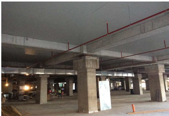
Avance de radier en edificio CDT
