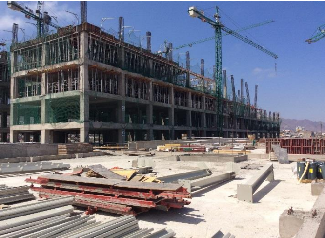
Avance en la colocación de hormigón en edificio Torre Hospitalización TH
