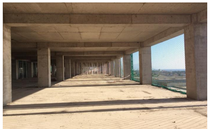
Avance losa nivel 5 edificio TH
