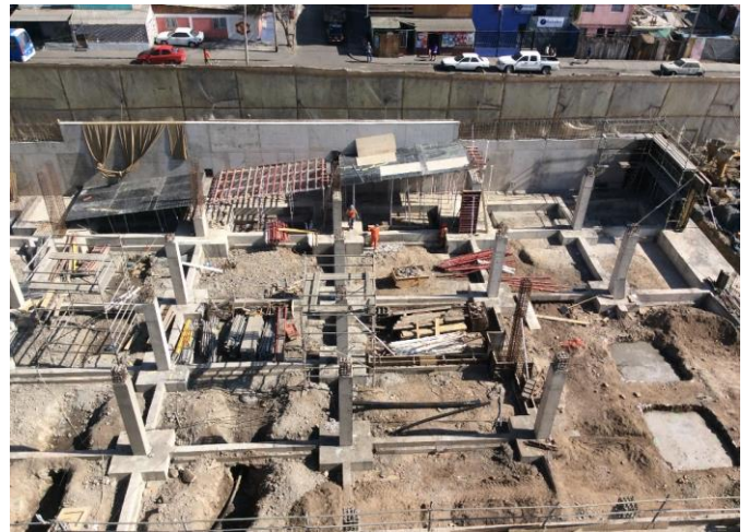
Control de enfierradura estacionamiento unidad de emergencia
